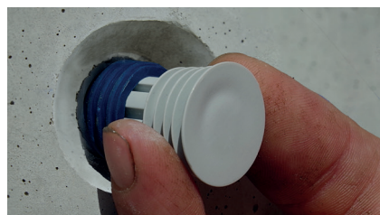
Positioneer de Sealing Plug in de afstandhouder
